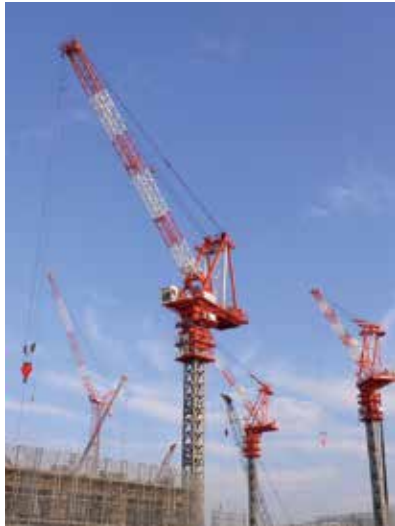
タワークレーン
