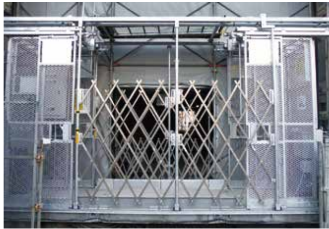
工事用エレベーター
